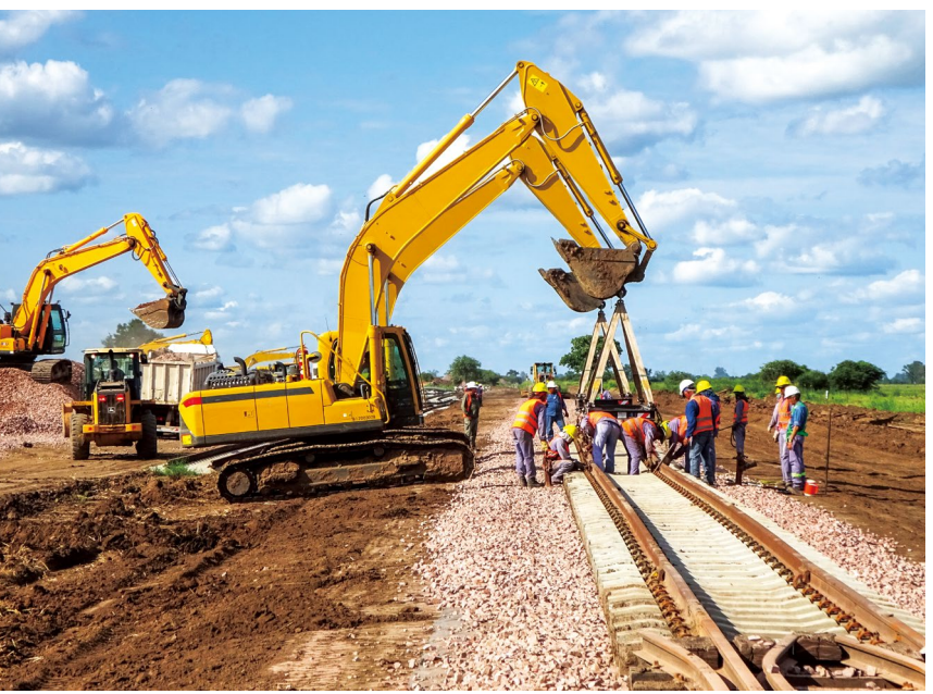
◆ 国机集团 CMEC 承建的阿根廷贝尔格拉诺货运铁路改造项目
